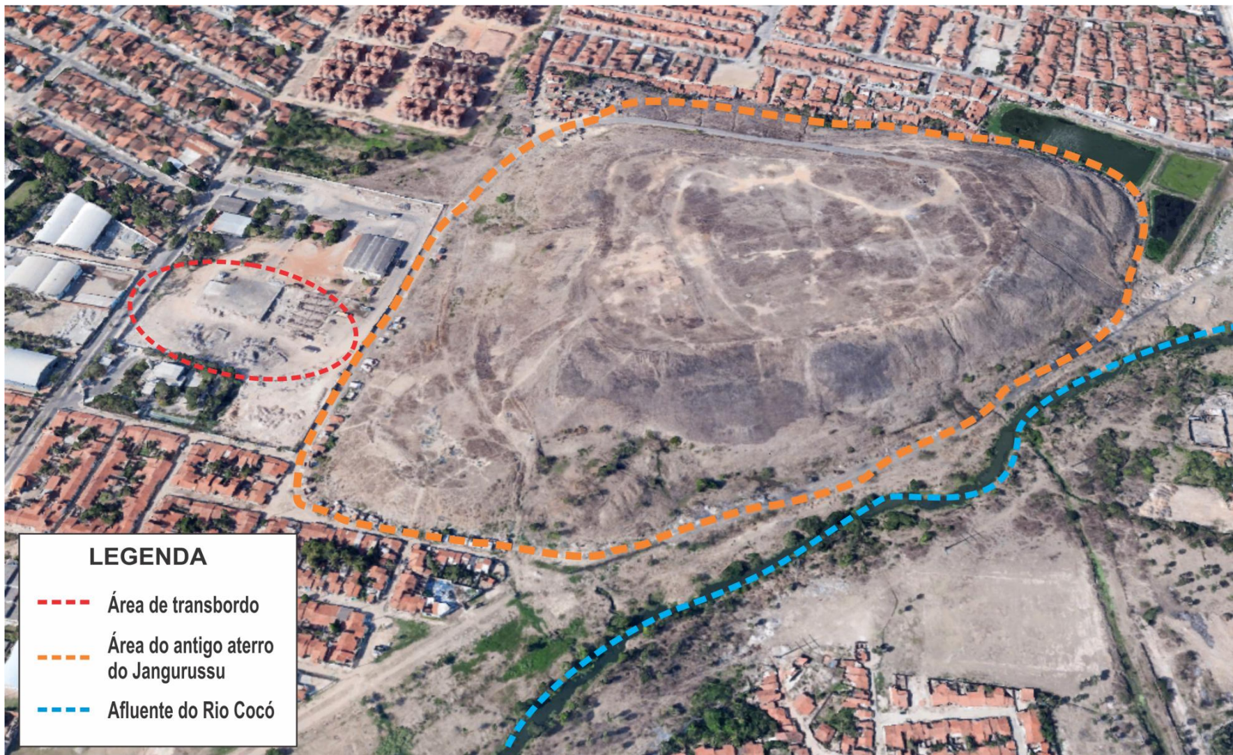
FIGURA Nº 82.0 – VISTA AÉREA APROXIMADA DO ANTIGO ATERRO DO JANGURUSSU COM DESTAQUE PARA A ÁREA DE TRANSBORDO
